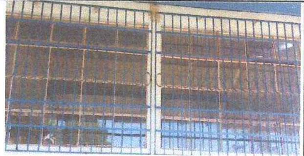
Foto 4: mantenimiento de balcones de metal
