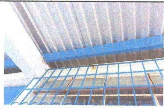
Foto 2: Sustrucción de estructura de soporte
