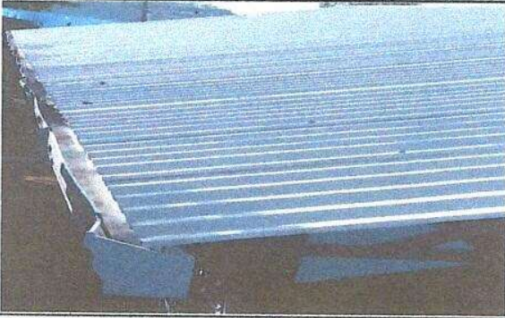
Foto 1: Sustrucción de lámina y sustrucción de capote
